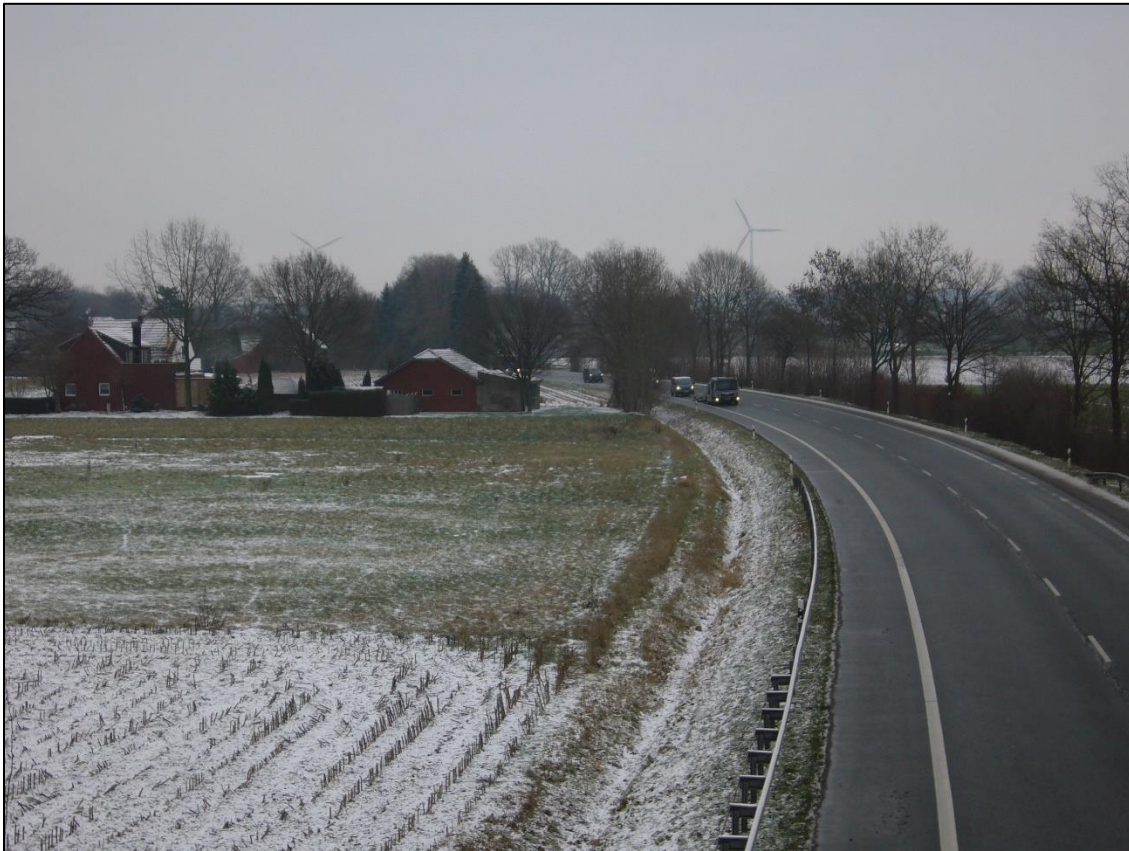
Abbildung 8: Blick von der Brücke Kleine Heide auf die Bundesstraße 525
