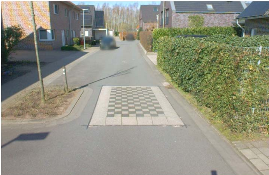
Bild 3: Beispiel einer Plateauaufpflasterung (Am Theater)
