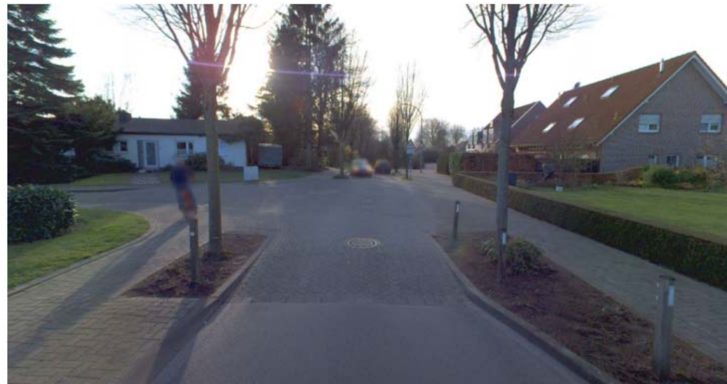
Bild 2: Beispiel einer Teilpflasterung (Adolph-Meyer-Straße/Kolpingstraße)
