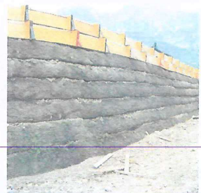
Polyslope T wird ohne permanente Schalungselemente errichtet; die "unschönen" Verformungen sind nach dem Aufgehen des Bewuchses nicht mehr sichtbar!
