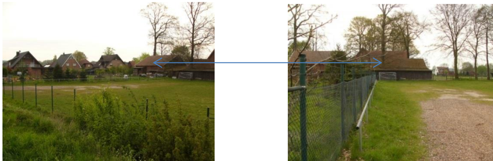
Abb. 4 a und b: Die Nebengebäude auf dem Hof Kalksbecker Weg 120, der Pfeil verweist auf das nördliche und südliche Gebäude
