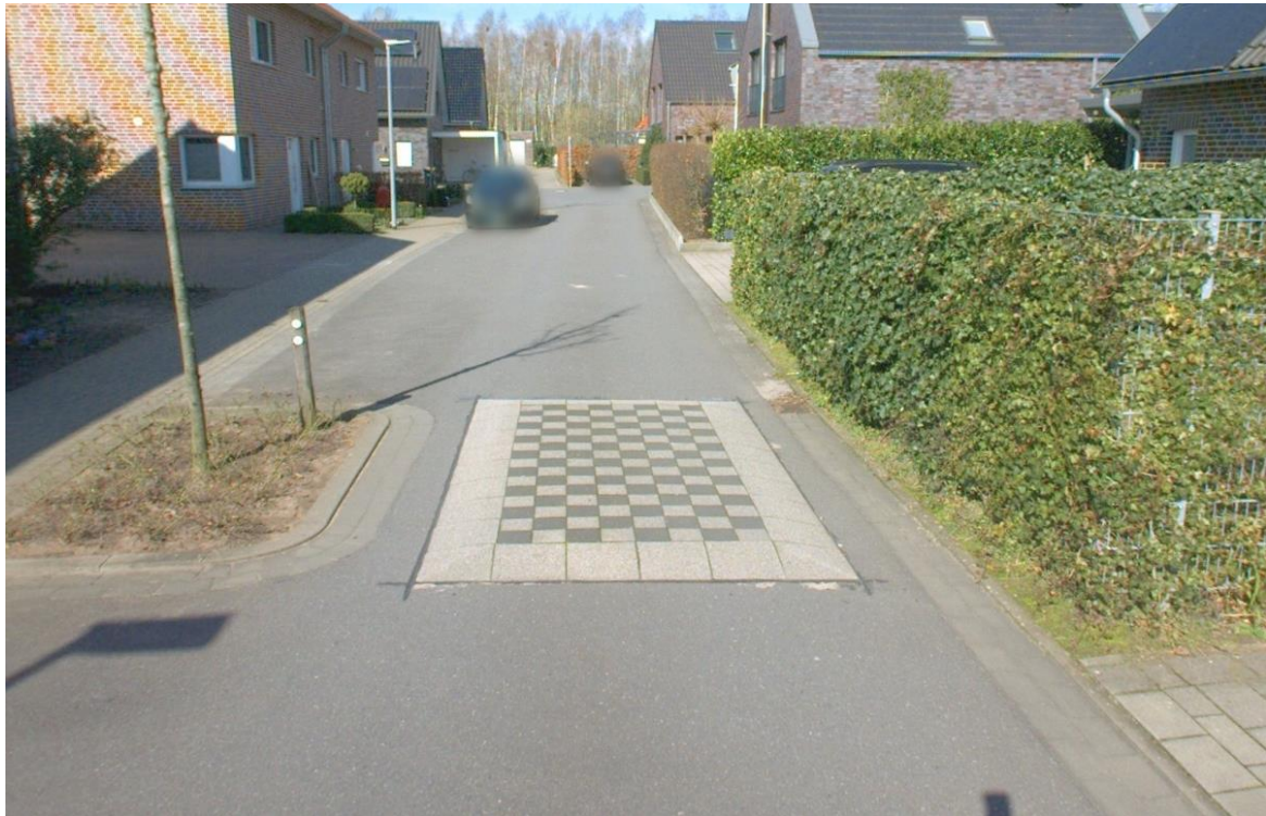
Bild 3: Beispiel einer Plateaufpflasterung (Am Theater)
