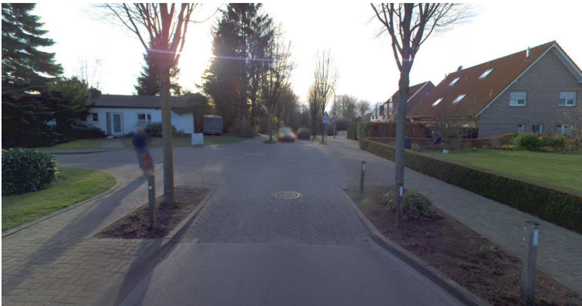
Bild 2: Beispiel einer Teilaufpflasterung (Adolph-Meyer-Straße/Kolpingstraße)
